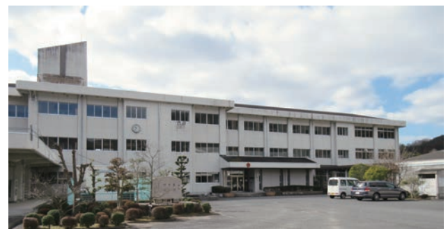
図2 F小学校の校舎（写真）。昭和63年に建築され、平成23年に閉校された校舎の外観。
