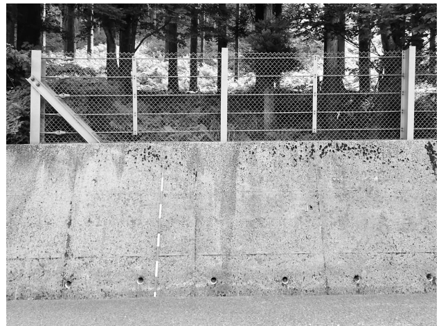
図6 道路沿いなどでよくみかける通常の落石防護柵。ここでは高さ2 mの擁壁上部に設置して、高さおよび裏側のポケット容量を確保している。なお、防護柵の支柱間距離は通常3 mであるため、区間長など距離測定に応用できる。
